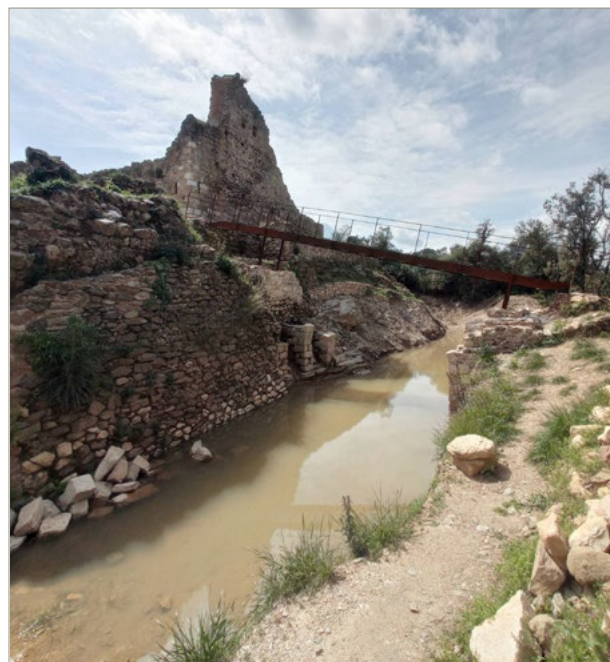
Figura 1. Castell de Juià. Vista del fossat, restes d'arrencada de les arcades del pont d'accés, nova passera sobre els nivells originals i, al fons, l'agulla de pedra i la tàpia que inicialment eren l'únic element visible del conjunt.
