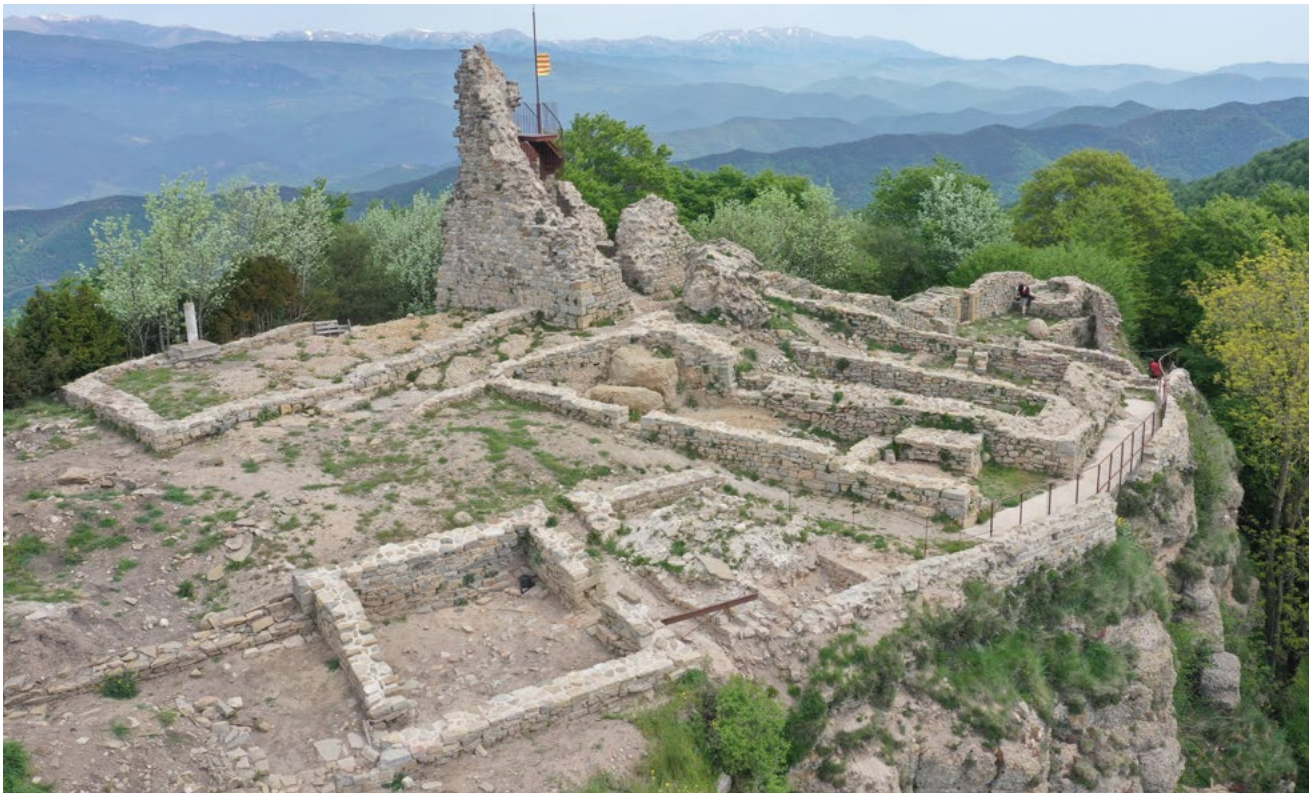
Figura 2. Castell de Milany. Vista aèria del conjunt, amb el camí de ronda sobre el cingle en primer pla i la torre amb el nou mirador al fons.
