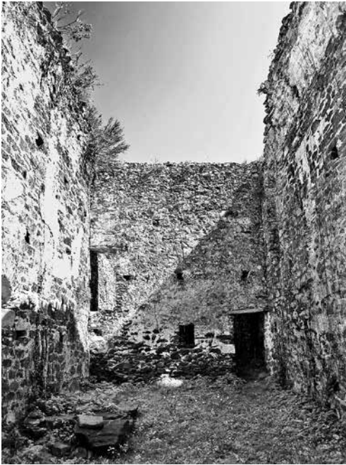
Fig. 2. En el moment d'iniciar la intervenció existia un mur que separava la nau de l'absis, construït amb posterioritat a l'abandó de l'església. De fet, convertia aquest sector en un petit habitatge.
