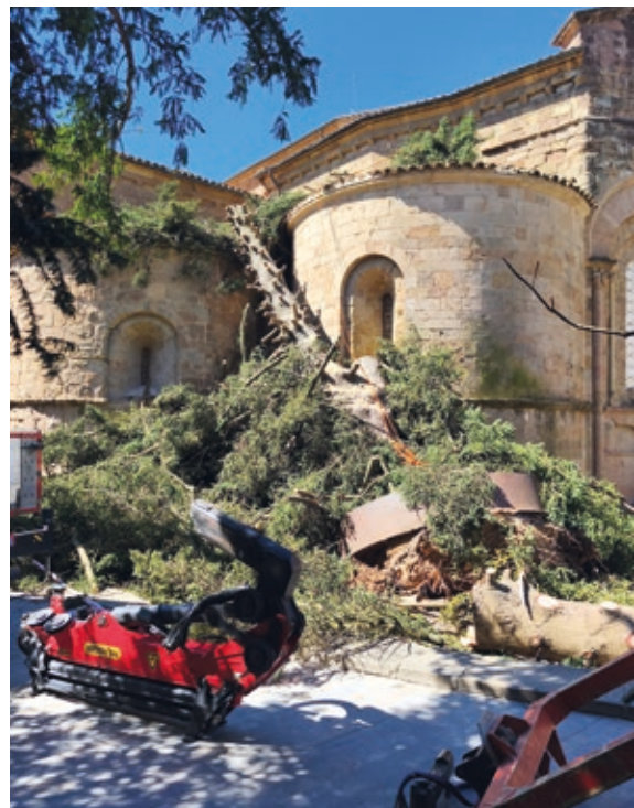
>> Efectes de la ventada de mitjan març al Ripollès.
