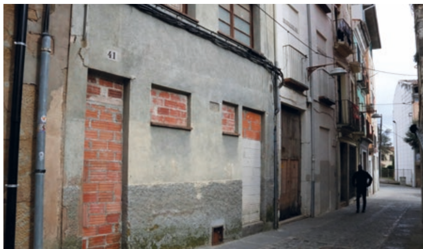
>> Accessos tapiats en un edifici del nucli antic d'Olot.
