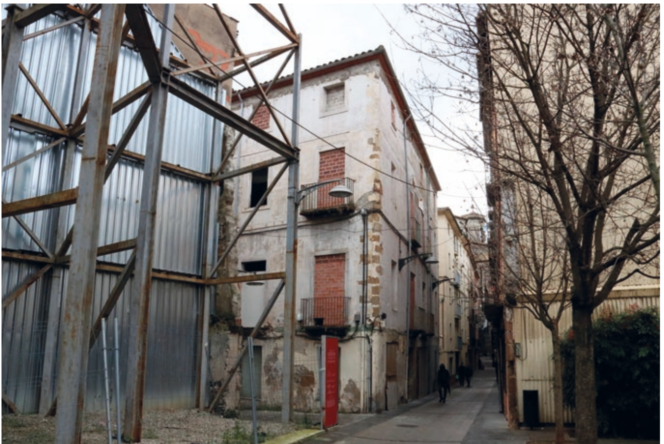
>> Un edifici tapiat al carrer dels Sastres, al nucli antic d'Olot.
