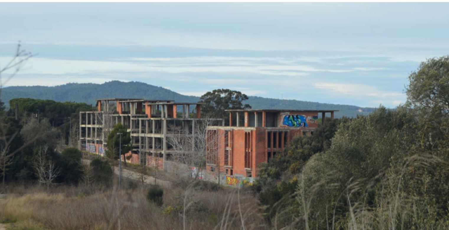
>> Estructura de formigó d'una promoció de més d'un centenar d'habitatges inacabats a Palafrugell. (Foto: Lluís Poch)
