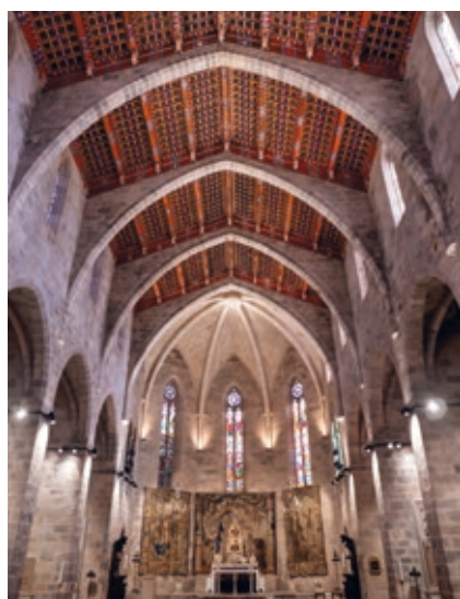
>> Sostre enteixinat de fusta de l'església del convent del Carme.
