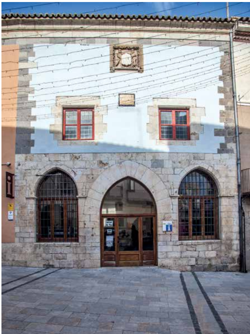
>> Casa del Consell de Castelló d'Empúries, actual seu del municipi. Es conserva parcialment la construcció del segle XIV del mestre de cases Joan Canelles, que també ho fou durant un temps de les obres de Santa Maria. (Foto: MANEL PUIG)
