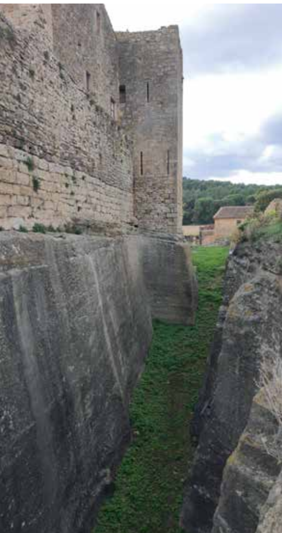
>> La muralla de Peratallada, reforçada per un ampli fossat excavat a la roca, és una imponent estructura defensiva d'origen medieval —amb trams dels segles XI al XIV— que exemplifica l'extracció de la pedra a peu d'obra i l'adaptació al relleu natural que envolta el castell. (Foto: CARME GÜELL)
