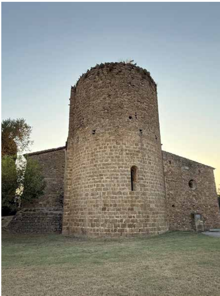
>> Absis romànic de l'església de Santa Maria de la Tallada (Baix Empordà), elevat i reforçat en època posterior per convertir-lo en part de la muralla. El recreixement és ben visible per la diferència en el tipus i la talla de pedra utilitzada. (Foto: PERE FREIXAS)
