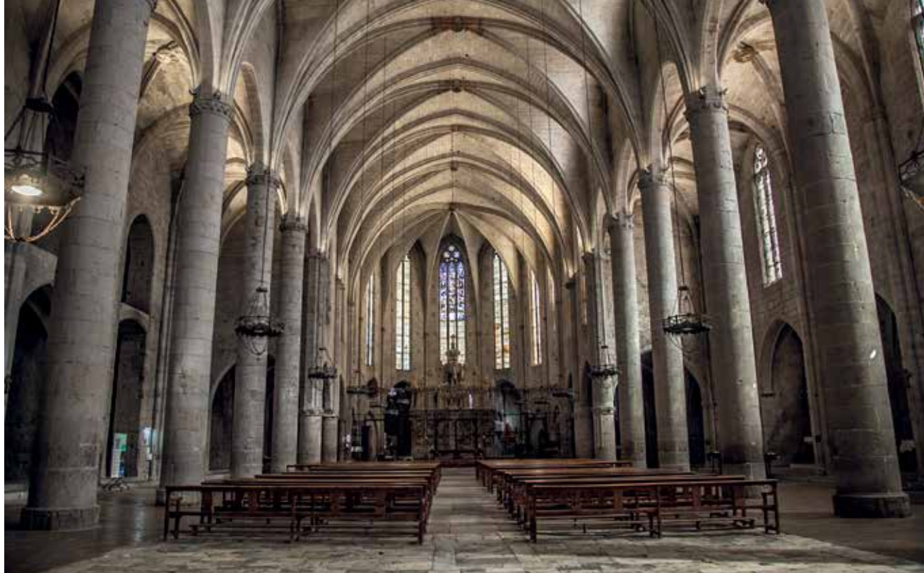
>> Santa Maria de Castelló d'Empúries. Interior de les tres naus cobertes amb voltes de creueria gòtiques sobre pilars circulars, obra iniciada el 1261 per Reinald de Chartres, mestre d'obres probablement francès. (Foto: MANEL PUIG)
