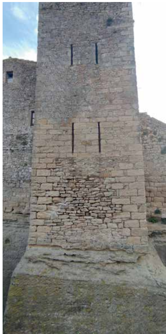
>> Torre de la muralla de Peratallada, edificada damunt la roca viva, de la qual s'extreia la pedra utilitzada en la seva pròpia construcció. (Foto: CARMÉ GÜELL)
