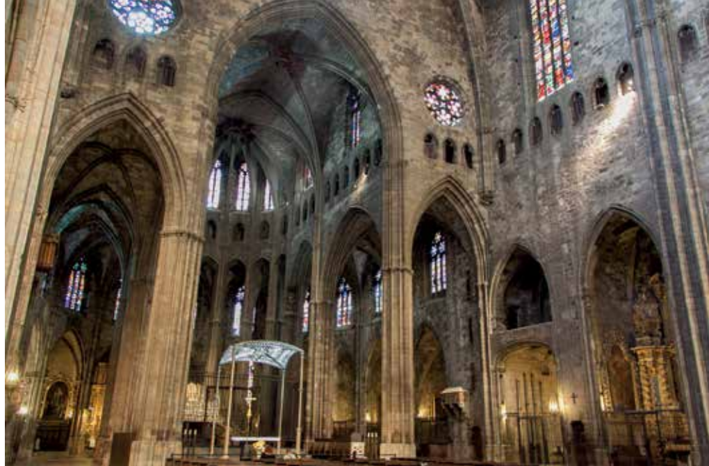
>> Catedral de Girona. Interior de la capçalera i primer tram de la nau. Des de Pedret arribava la pedra per a la construcció de la catedral, extreta directament de la pedrera de la seu o d'alguna de les que els mestres pedrers tenien el domini útil, com era el cas dels Sans, els principals proveïdors de pedra a la segona meitat del segle XIV. (Foto: CAPÍTOL DE LA CATEDRAL DE GIRONA)
