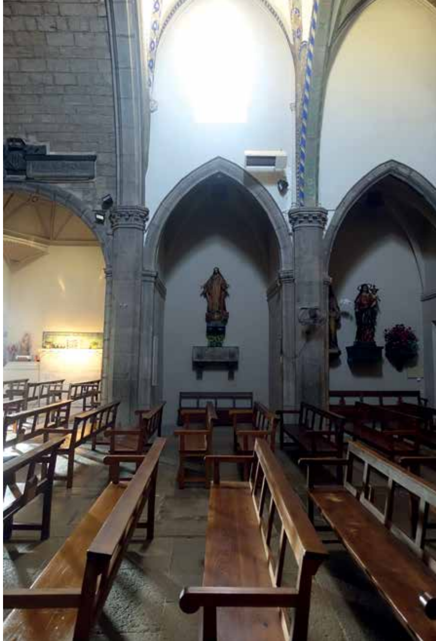
>> Alçat longitudinal de les capelles laterals sud, amb l'arc de mig punt obert antigament al mur romànic, l'arc apuntat de nova formació al centre i l'arc apuntat conservat a la dreta.
