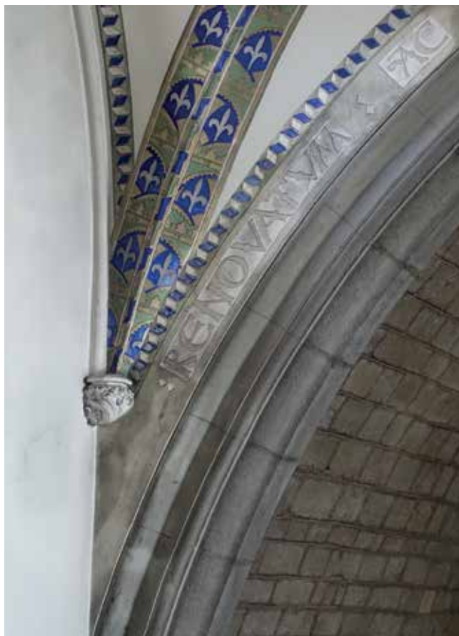
>> Arrencada del nervi nord-est de la volta de creueria contigua a la volta romànica, amb el motiu d'una flor de lis blanca sobre fons blau, i inici de la inscripció situada a l'extradós de l'arc que separa la part antiga de la reconstruïda per Rafael Masó. (Foto: LAIA DE QUINTANA)
