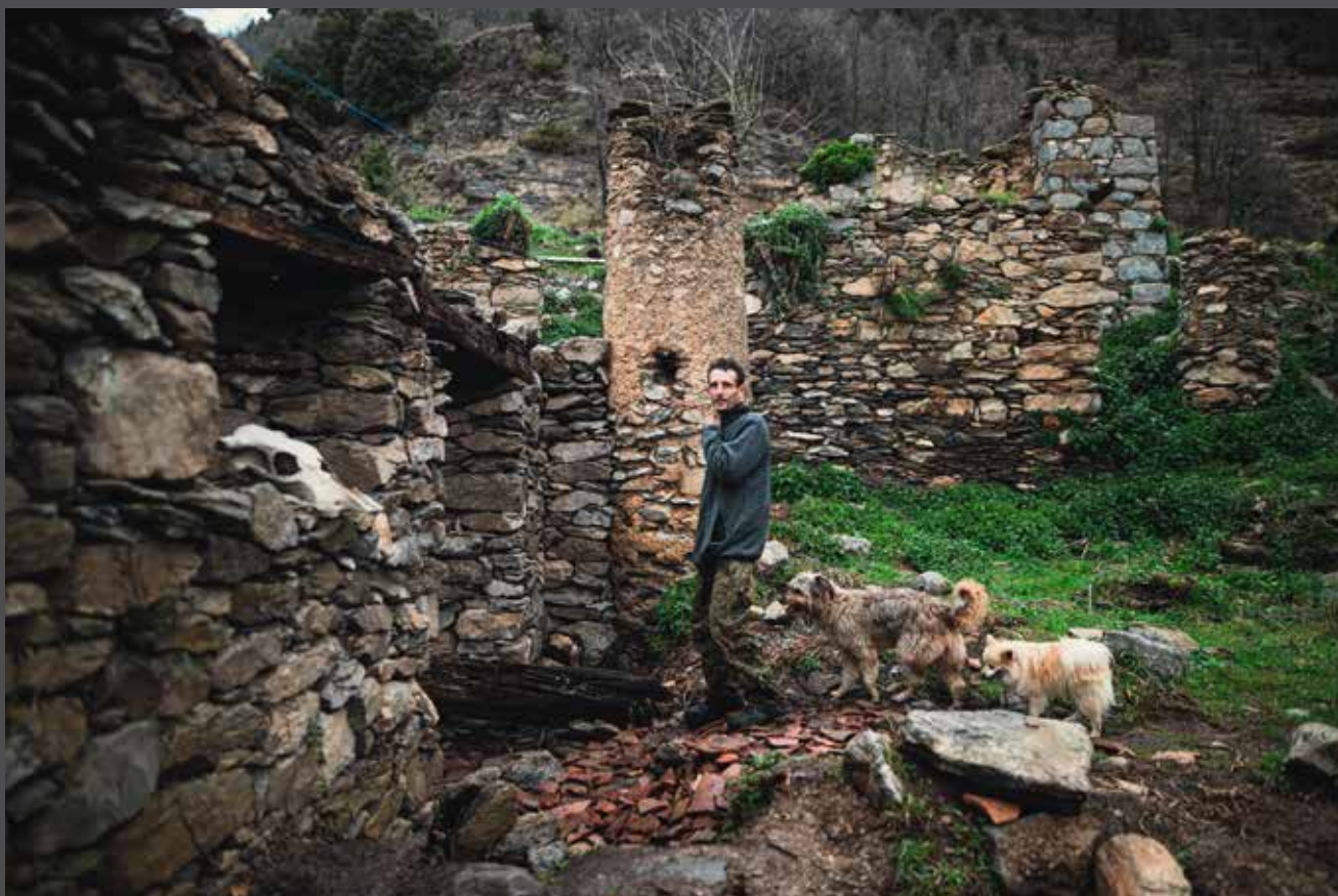
>> La reconstrucció del casalot suposa una feina ingent.
