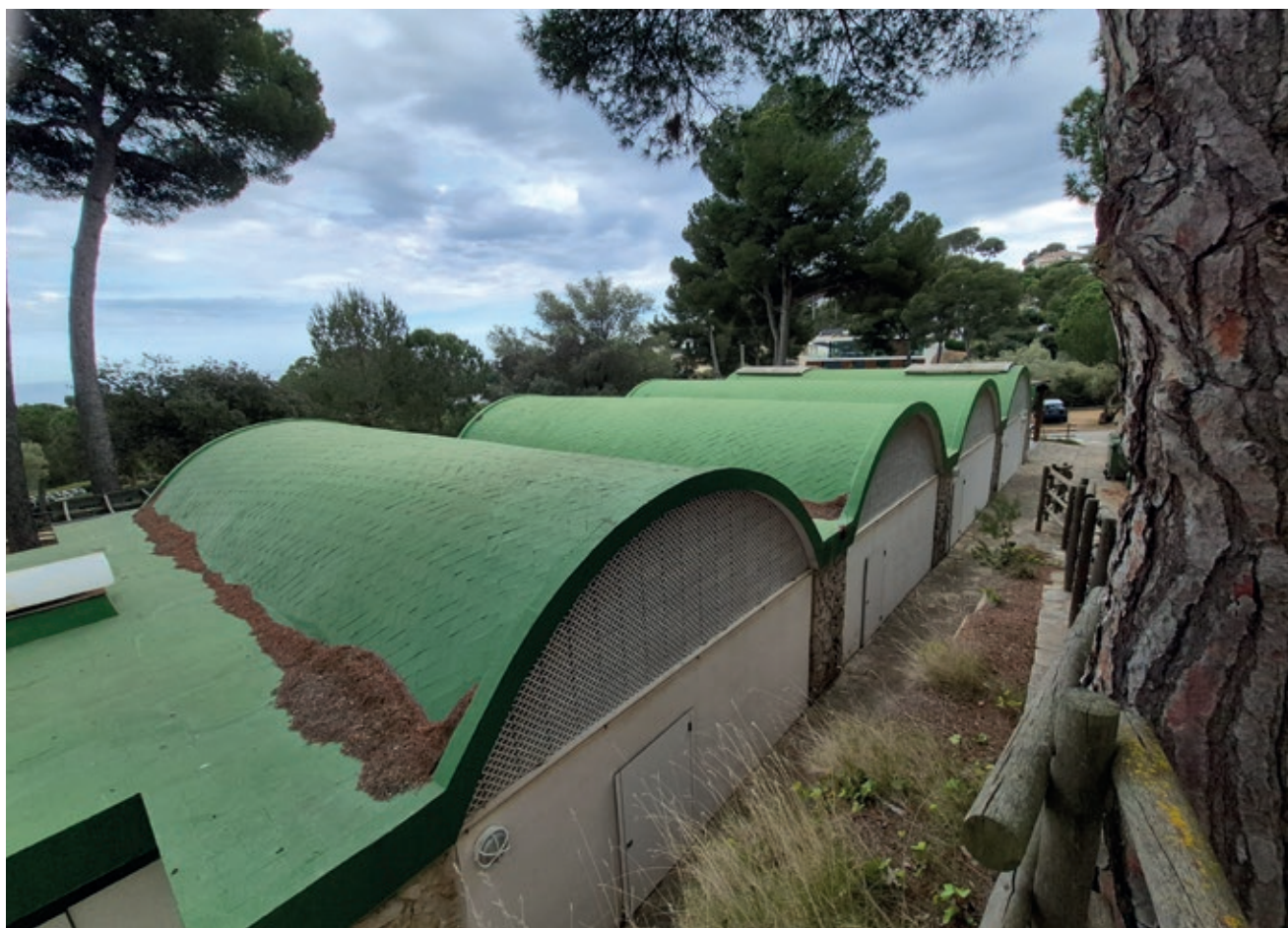
>> Construcció del Càmping Cala Gogo (inicialment, Mediterráneo) amb voltes catalanes, un sistema constructiu que funciona per mòduls. (Foto: ALBERT VILAR MASSÓ)
