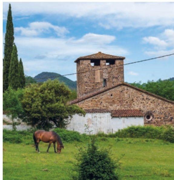
>> Església de Santa Eulàlia de Begudà.
