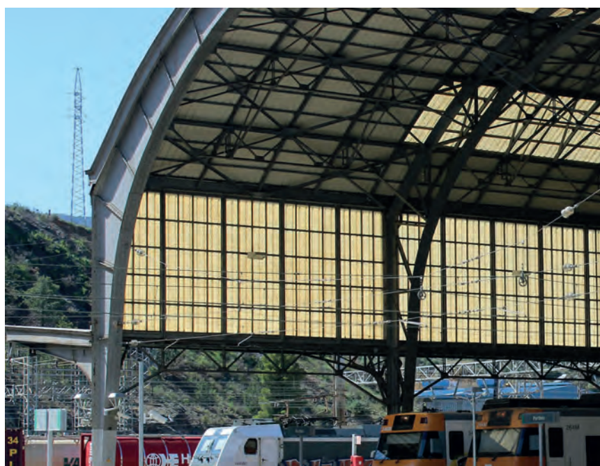
>> La marquesina de ferro i vidre cobreix les andanes i l'edifici administratiu i d'atenció al públic.
