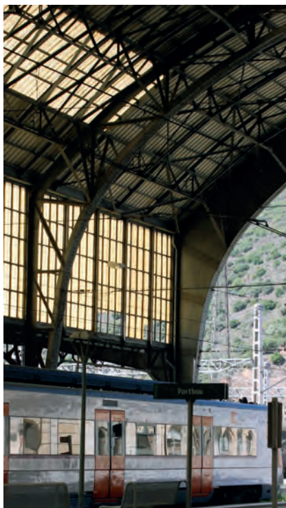
>> La marquesina translúcida va ser construïda als tallers de Joan Torras i Guardiola.
