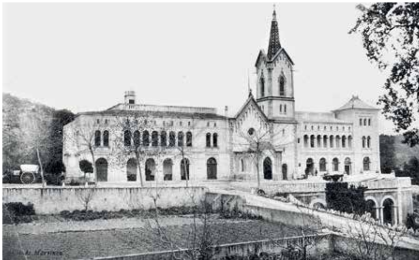
>> Santuari de la Mare de Déu de Gràcia al paratge de Sant Pere del Bosc de Lloret de Mar (ca. 1920). Foto: SAMLM. FONS FÀBREGAS BARRI (AUTOR DESCONEGUT).
