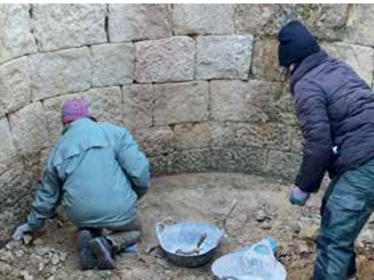
>> Treballs de neteja de la cisterna de Castell. (Foto: MAC)
