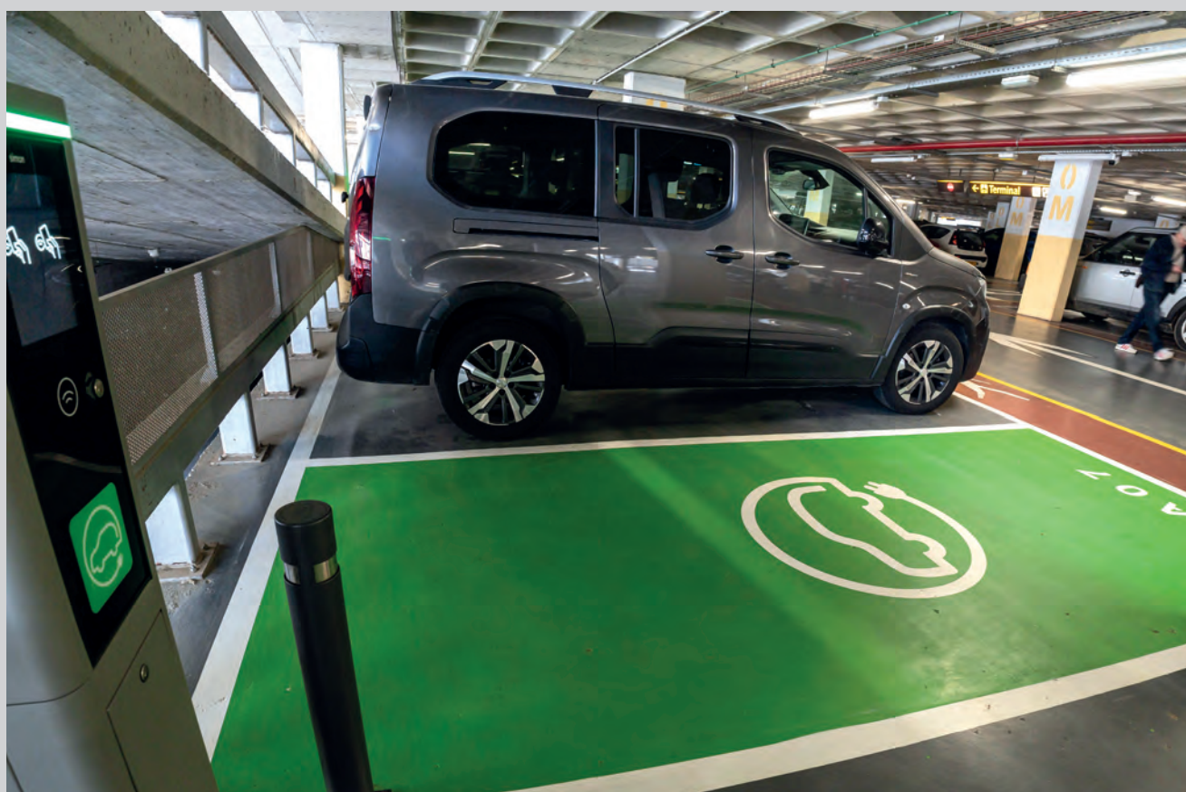
>> Aparcament per a vehicles elèctrics.
