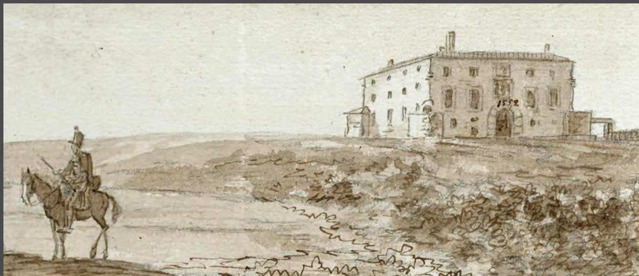
>> Torre de la Pabordia (?).
