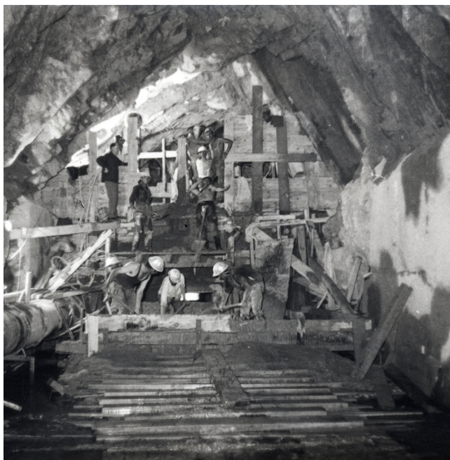
>> Treballs de construcció de la presa. (Font: CONFEDERACIÓN HIDROGRÁFICA DEL PIRINEO ORIENTAL)
