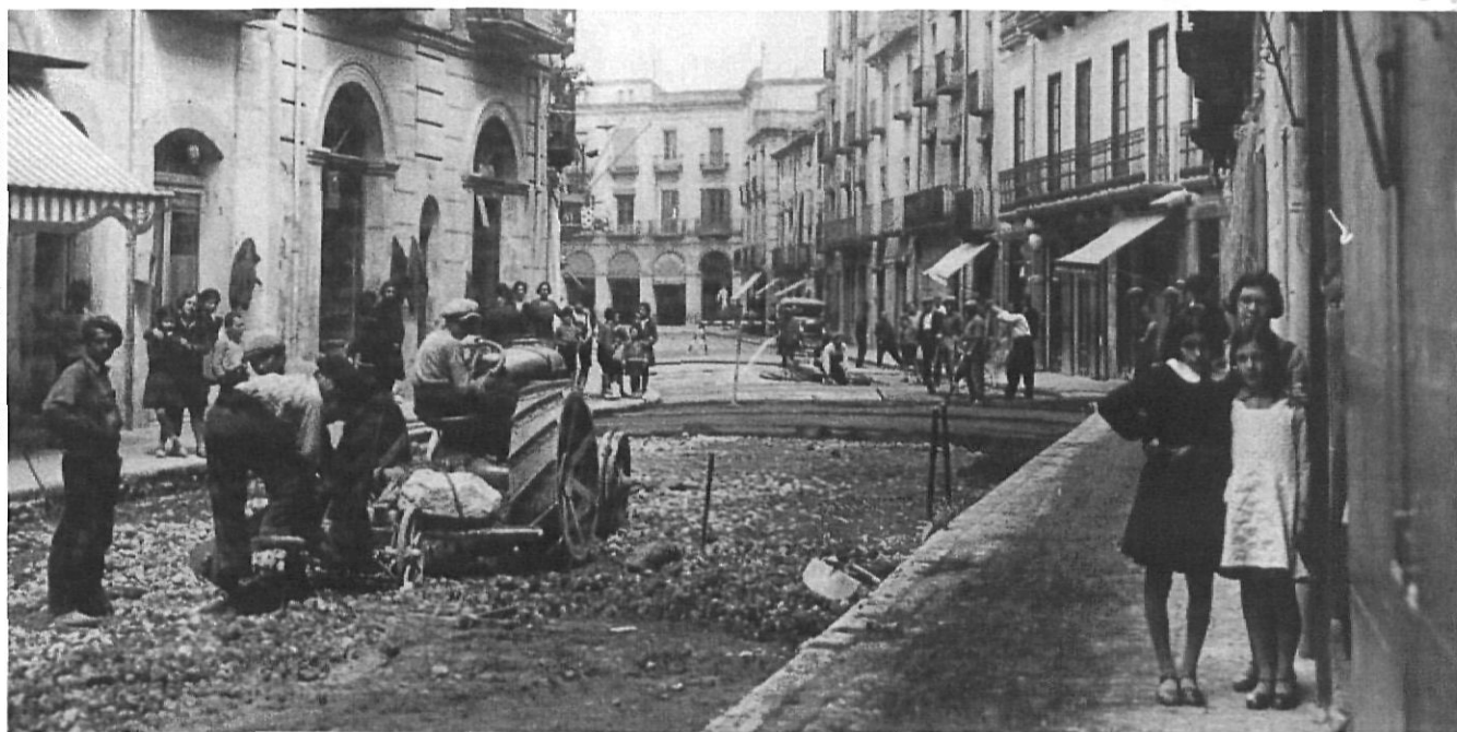
Obres de pavimentació de carrers, concretament el carrer Ample, l'any 1933.
