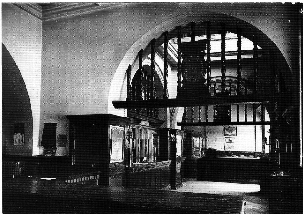
L'estil de Rafael Masó es feia evident en el vestibul de la casa núm. 1 de la pujada del Pont de Pedra de Girona.
