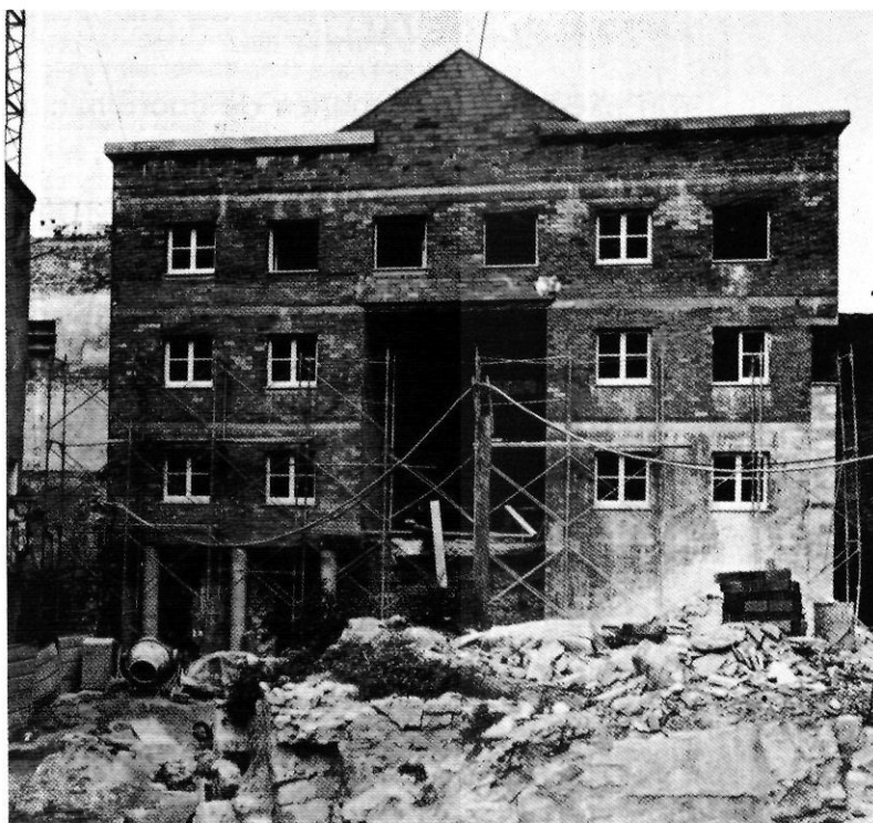
La "casa lila" en construcció.
