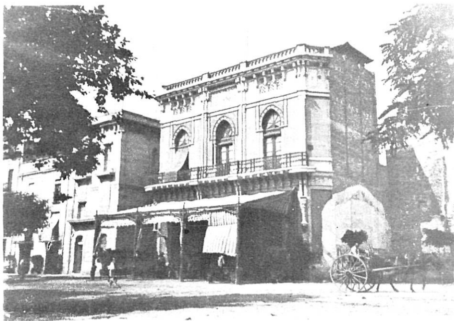
El primer edifici de "La Constancia", inaugurat el 1889. En aquesta interessantíssima fotografia hom pot veure, darrera del carro, l'empremta de la casa enderrocada; per tant, més o menys deu ésser de l'any 1898. Fotografia d'A. Matas; original facilitat per Antoni Vidal.
