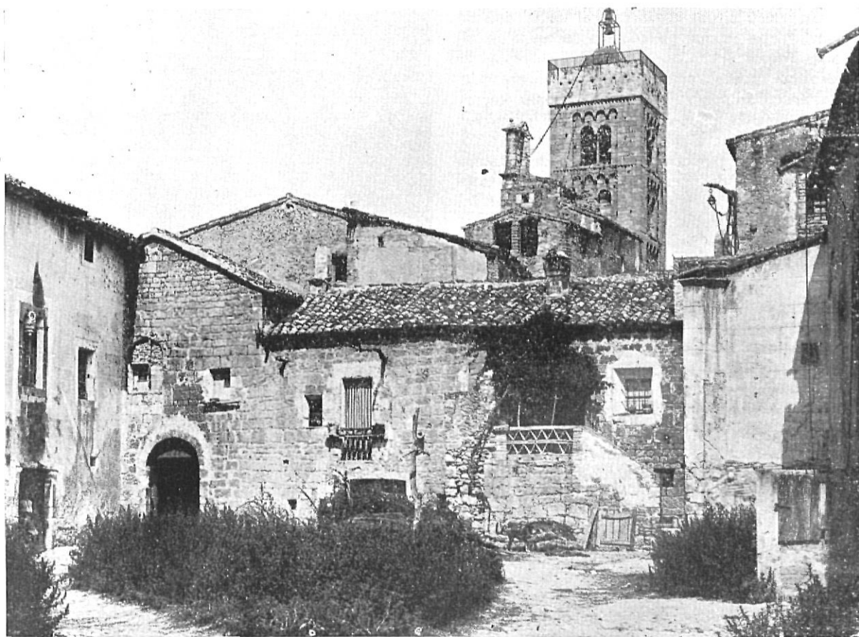
Pati d'armes de l'abadia que demostra el llastimós estat en què es troba actualment
