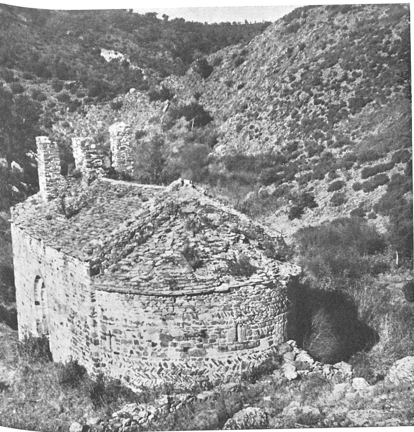
La nave de planta rectangular en un banco de mampostería adosado alrededor del muro, cubierta toda ella con bóveda de medio punto, el ábside semicircular, Figs. 1, 2, 3, 4 y 5. Construida de mampostería excepto la puerta de entrada que es de piedra labrada, adintelada con tímpano y dos archivoltas y las tres ventanas, una en el frontis de la nave, otra en la fachada, todas de doble derrame, la del ábside de un solo.
