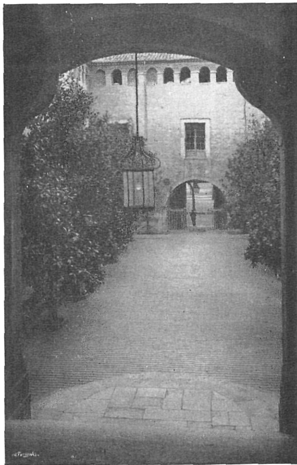
Vista interior del patio del Hospital
