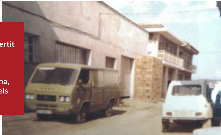
Inici de la construcció de l'actual obrador.
