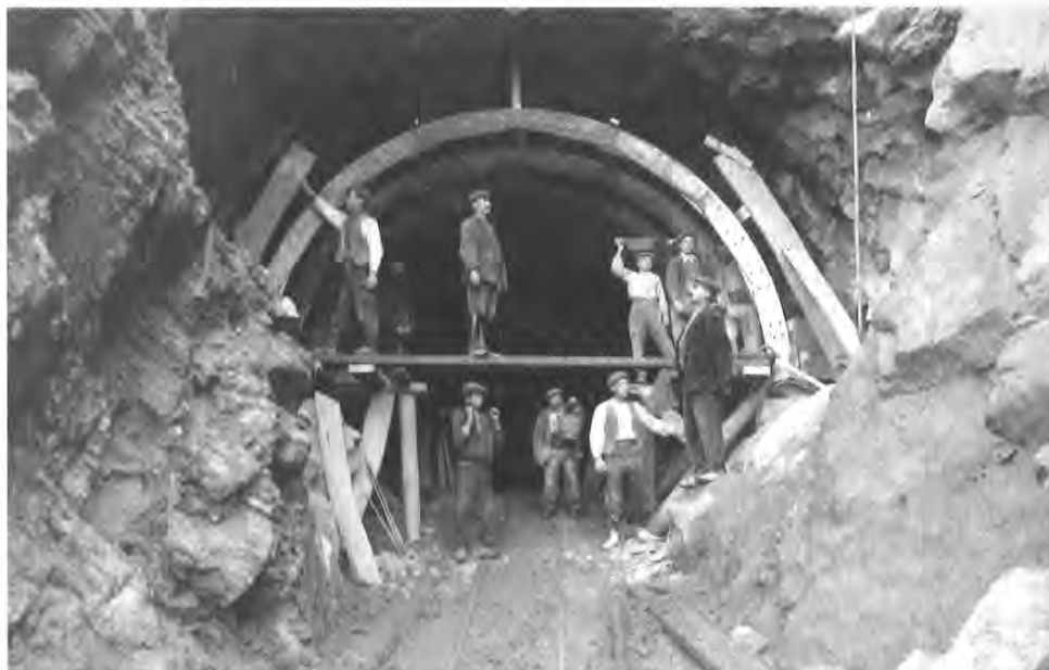
Escena de les obres del túnel del ferrocarril de Ripoll. Obrers enfilats en una bastida de fusta en l'interior de la roca foradada. (Foto AIEMB de la Diputació de Girona)
