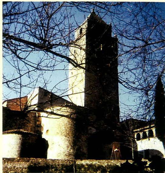
Campanar de planta quadrada de l'església de Sant Llorenç. L'estructura sobreposada en forma de temple és un possible comunidor per conjurar les tempestes.
