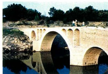
Pont de Riambau, derruït i reconstruït en diverses ocasions i actualment sota les aigües del pantà de Darnius-Boadella. Per la seva situació a la capçalera del pantà, els estius sobresurt de les aigües amb relativa freqüència.
