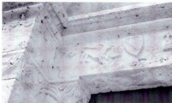
Escuts de pedra de la porta de les Dones de l'església de Bàscara.
