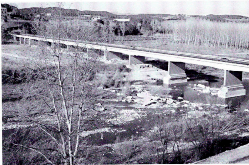
Restes de l'antic passallís, visibles a prop de l'actual pont del Fluvià.
