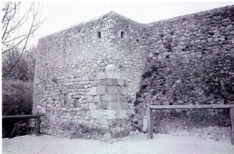
El flanc sud del recinte emmurallat estava protegit per una torre de planta quadrada.
