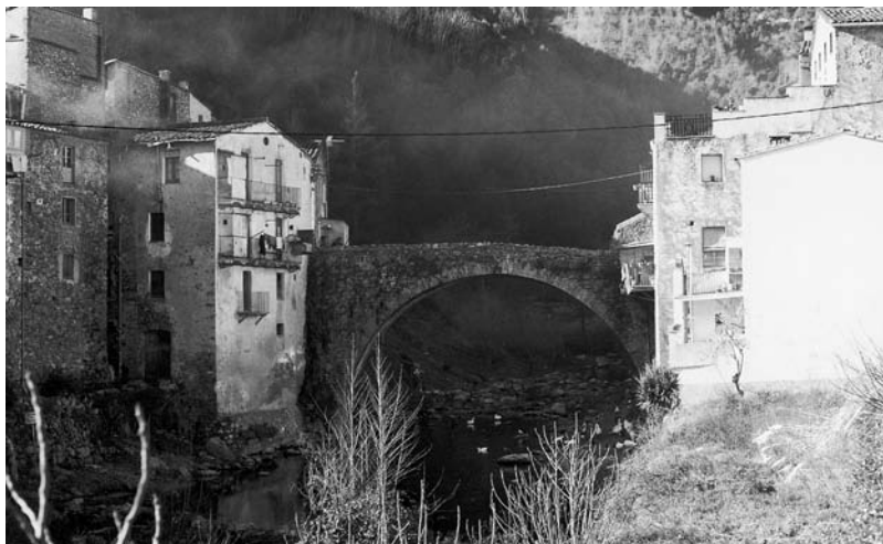
La imatge tradicional d'Osor és el pont sobre la riera. Aquest pont almenys té dos arcs més que no es veuen, car resten sepultats sota alguns edificis propers al pont.
