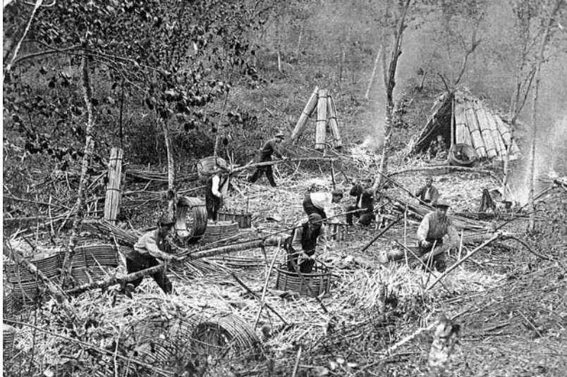
Grup de roders treballant en un esteller construït al mig del bosc. Fotografia feta durant la primera dècada del segle XX.
