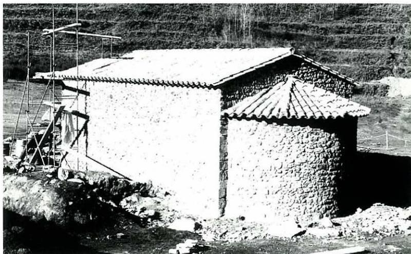
Restauració de l'ermita de Santa Margarida.
