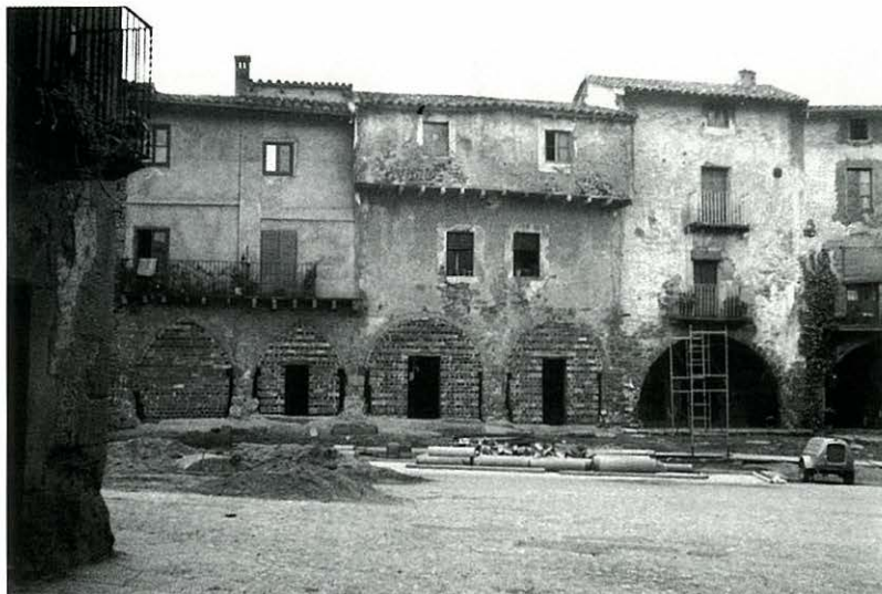
Restauració de les voltes de la plaça de Dalt.
