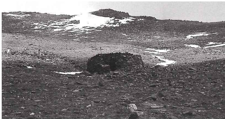
Construcció, a l'alta vall del Freser -prop del coll de Tirapits-, (juny 1995).
