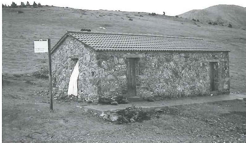
Aquest refugi forestal està en condicions òptimes i ens pot acollir per realitzar una sortida en aquest sector (octubre 1995).
