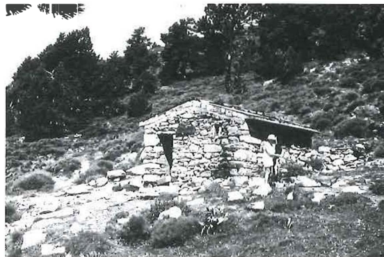
Situat a 2.123 metres d'altura, el refugi Aragó compta amb una situació estratègica per ascendir al cim per la seva famosa xemeneia.
