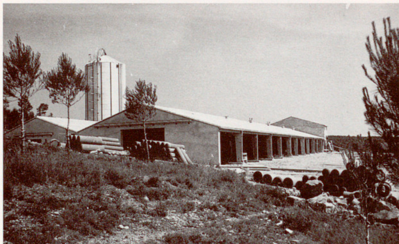
Construcció de les instal·lacions ramaderes a la Granja Camps i Armet, de Monells (el Baix Empordà), (1969).
