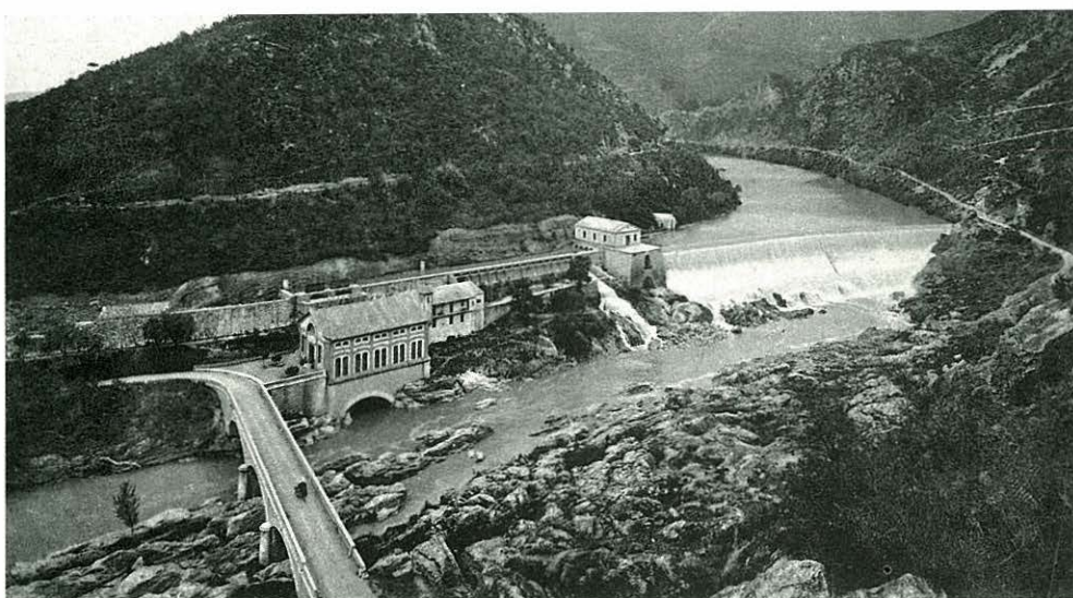
Visió retrospectiva del Pasteral, al sector nord del terme, amb l'antiga central hidroelèctrica, avui desapareguda. La Muntanya de Canet, que es veu al fons, mal coneguda com a Colldegria, estava completament pelada a causa de l'extrema explotació a què se la sotmetia.
