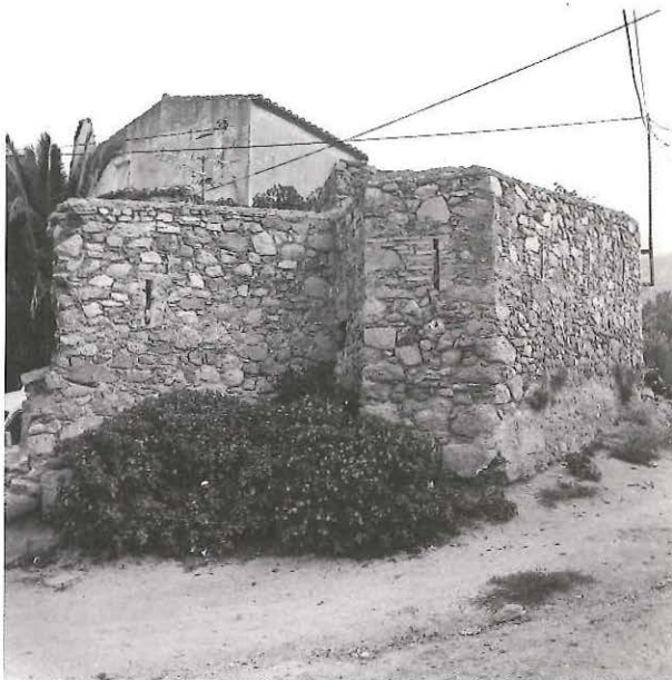
Restes actuals del Llatzaret, edificat l'any 1831.
