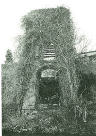
La força dels Predicadors, l'antic fossat per on transcorre el rec del Moli i el Portal de la Gallarda són alguns dels pocs exemples que resten de les antigues fortificacions medievals.
