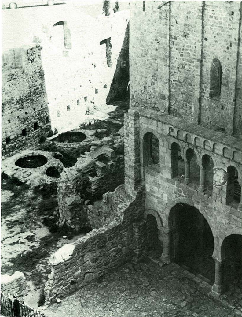
Les excavacions que es feren al peu de la torre del Fum provenen la preexistència d'un nucli cristianitzat instal·lat allà entre el s. II i el V dC.
