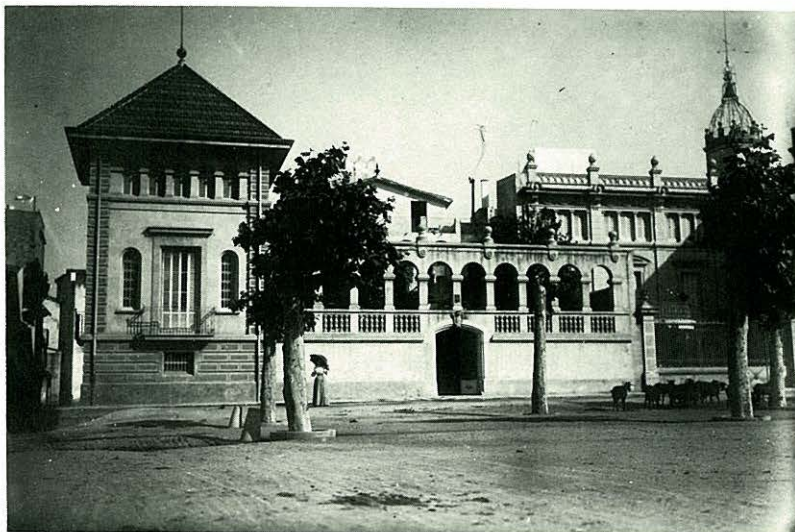
Casa Llagostera (1889-1890). A la darrereria del segle passat el Passeig més apreciat per la nova burgesia. Avui la majoria d'aquests edificis jo no existeixen: han estat enderrocats i substituïts per uns altres que no ofereixen cap mena d'interès artístic.
