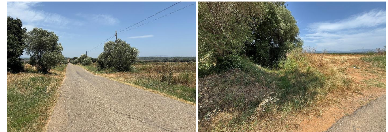
Figura 2. Ubicació de l'obra de drenatge núm. 1 i detall del drenatge natural existent.
