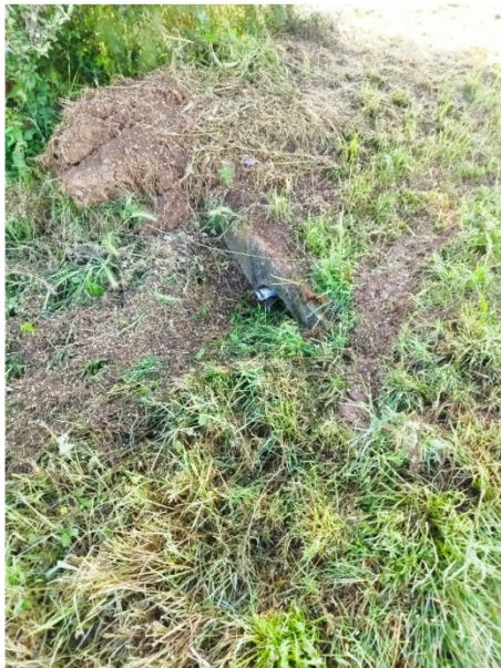
Obra de drenatge amb el tub tapat de terra..
