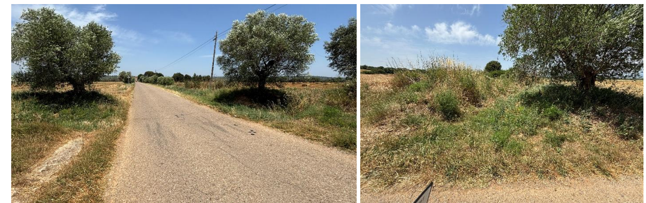
Figura 3. Ubicació de l'obra de drenatge núm.2 i detall del drenatge natural existent.
