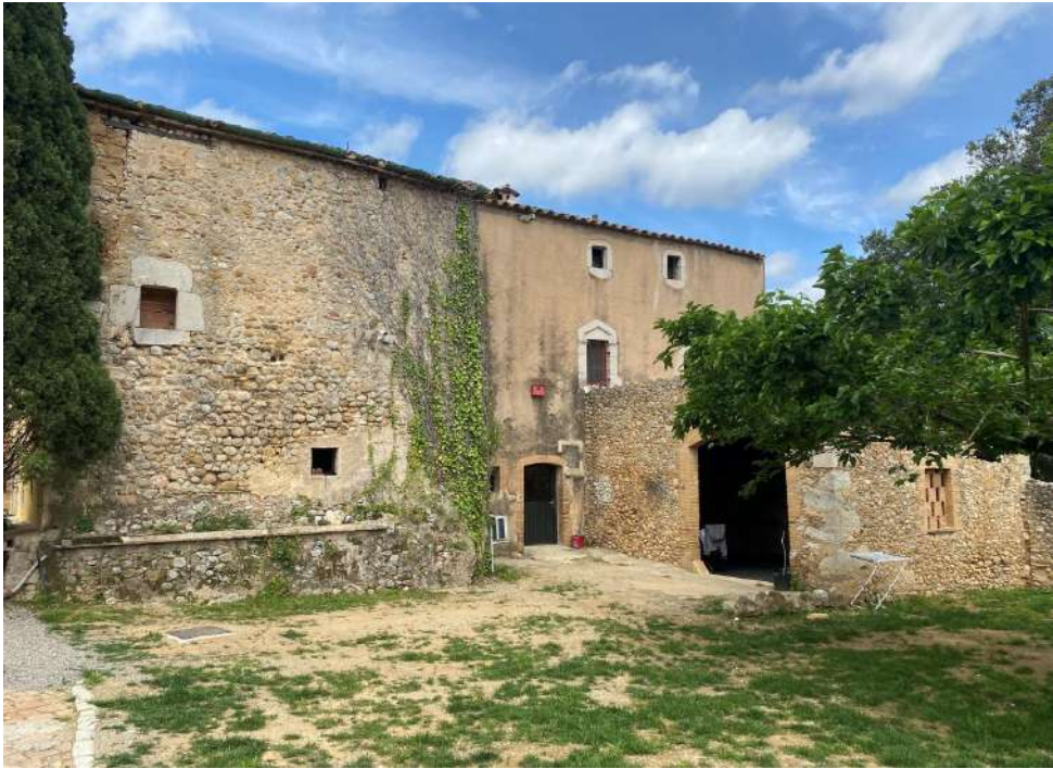
Vista de la masia de Ca l'Arrufat, façana est, juntament amb el cobert auxiliar en planta baixa
