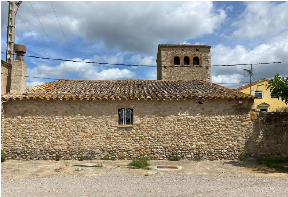
Vista de l'antiga construcció auxiliar agrícola de la masia de Ca l'Arrufat, façana sud
