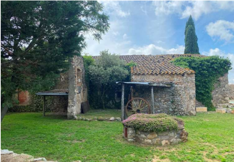
Vista de la masia de Cal Cuc, façana nord
