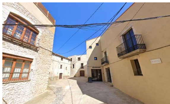
Imatge de l'estat actual de la Placeta
