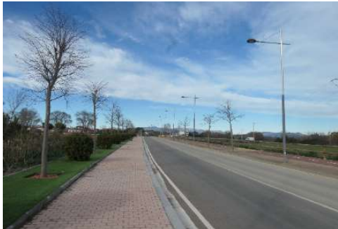
Carretera GIV-6228, tramo entre Vilamallà y el Pont del Príncep
