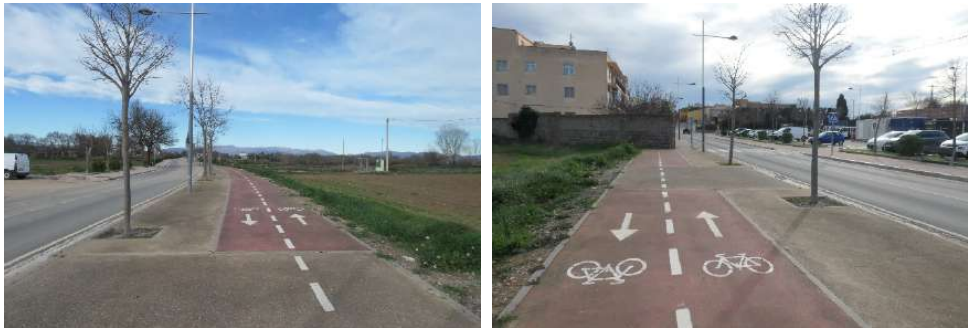
Carril bicicleta por el lado este de la carretera GIV-6228 Carril bicicleta por el lado este de la carretera GIV-6228
