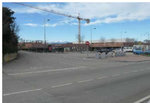
Parada de bus Vilamallà Poble y escuela en construcción; el itinerario a pie discurrirá por aquella acera
