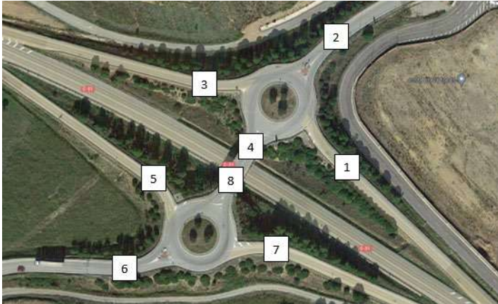
Figura 10. Conjunto de las dos rotondas del enlace de la C-31 analizadas
