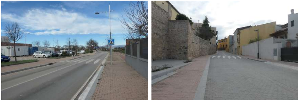
Paso de peatones elevado a la carretera GIV-6228 Entrada al núcleo urbano de Vilamallà, c. Figueres
