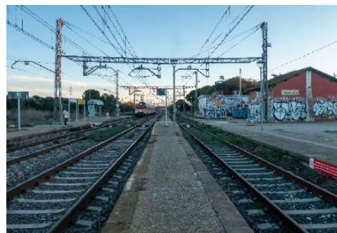
Andenes de la estación de Vilamallà con un tren de la línea R11 a punto de parar en la vía 1
