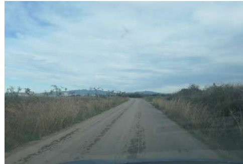
Carretera del Riberal actual, sin espacio específico para peatones. El desarrollo del sector SUD-1 prevé la creación de un nuevo viario con un itinerario para peatones segregado y accesible
