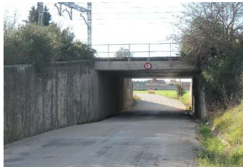
Carretera del Riberal, paso bajo el ferrocarril
