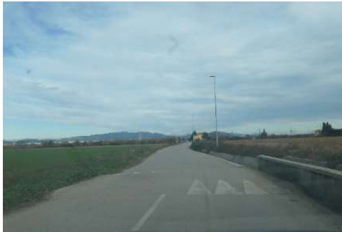
Carretera del Riberal, elementos de reducción de la velocidad en la zona próxima al núcleo de Vilamallà
