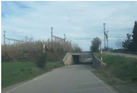
Carretera del Riberal, paso bajo el ferrocarril
