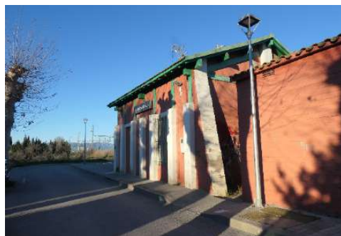
Edificio de viajeros de la estación de Vilamallà de ferrocarril
