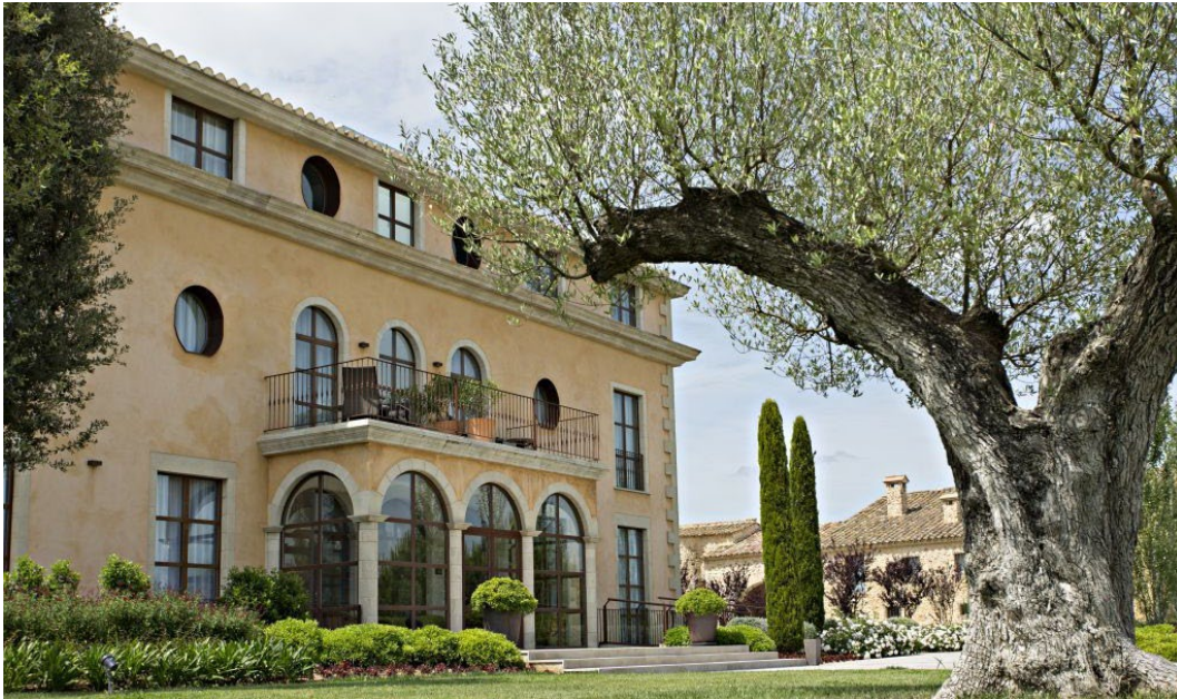
FONT WEB. EDIFICACIÓ PRINCIPAL DE L'HOTEL. FAÇANA NORD
