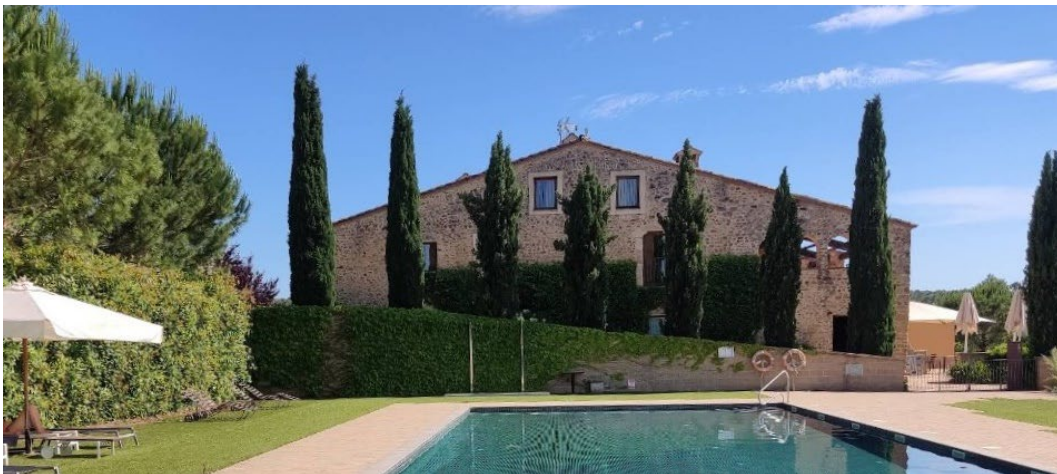
FONT WEB. EDIFICACIÓ MASIA GRAN. VISTA DES DEL NORD
