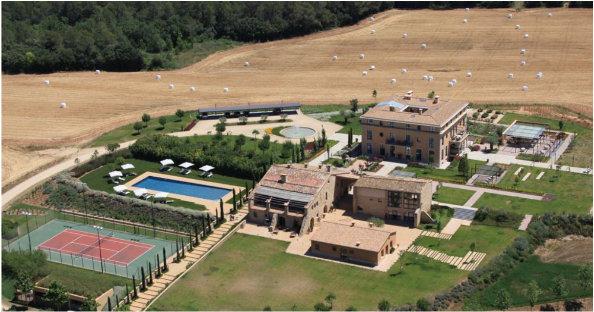
FONT WEB. VISTA AÈRIA GENERAL DES DE L'OEST
