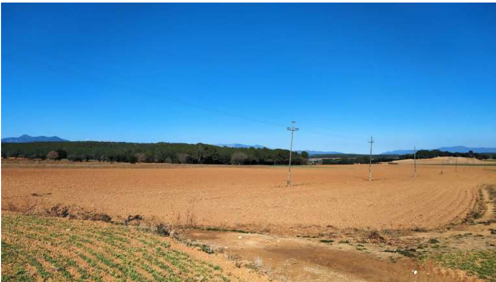
Vista 2 – Tram de la línia aèria existent que s'ha de reforçar, adequar o reformar.
