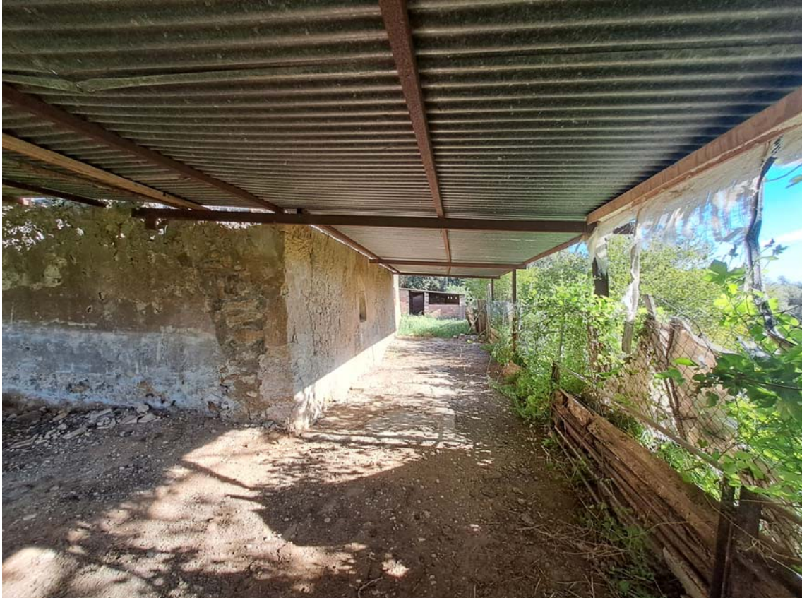
Imatges del cobert adossat a oest amb estructura metàl·lica.
