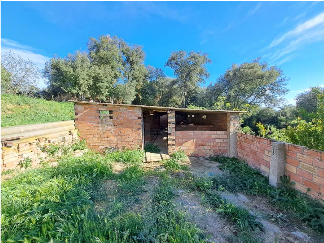
Imatges del cobert a sud d'estructura ceràmica.
