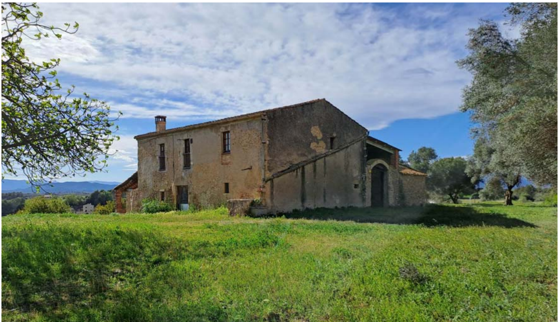
Imatge de les façanes sud-est del volum principal.
