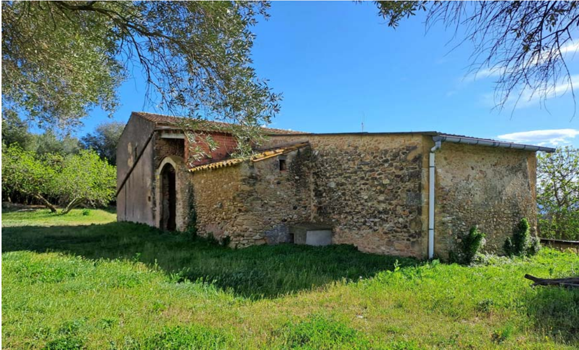
Imatge de la façana est dels volum secundaris.
