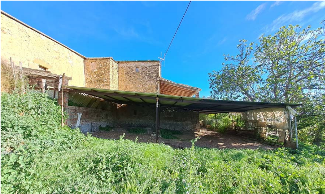
Imatge del cobert adossat a oest amb estructura metàl·lica.
