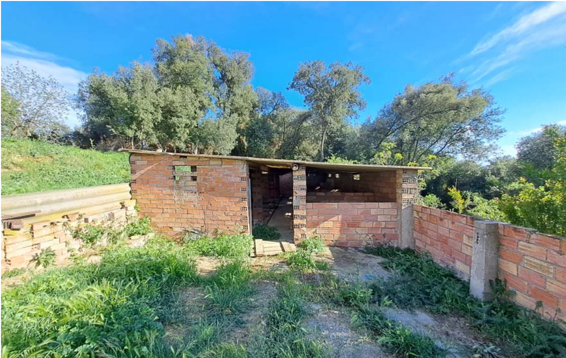
Imatges del cobert a sud d'estructura ceràmica.
