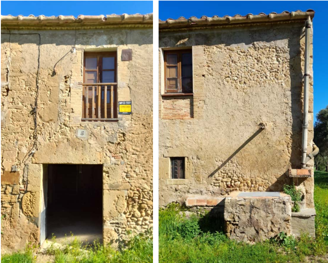
Imatges reals de la façana i del seu estat de conservació.
