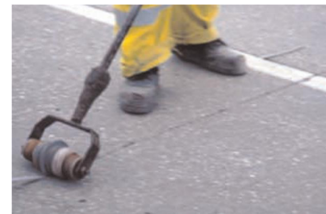
Figura 75. Imatge instal·lació d'obturgador en el fons del tall.
