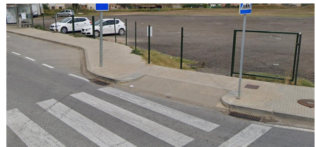
Figura 21. Gual de vianants, només compliment parcial de la normativa. Manca paviment indicatiu.
