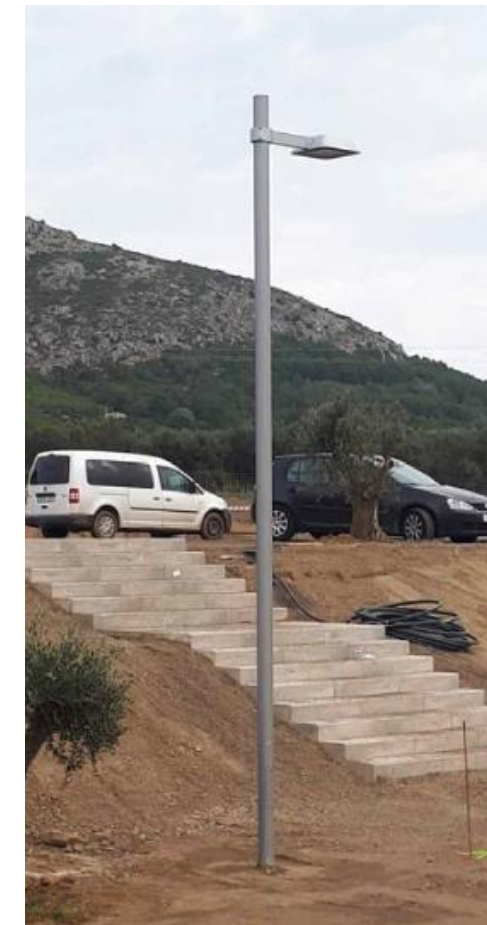
Figura 28. Lluminària a instal·lar. Model tipus Town de Salvi.
