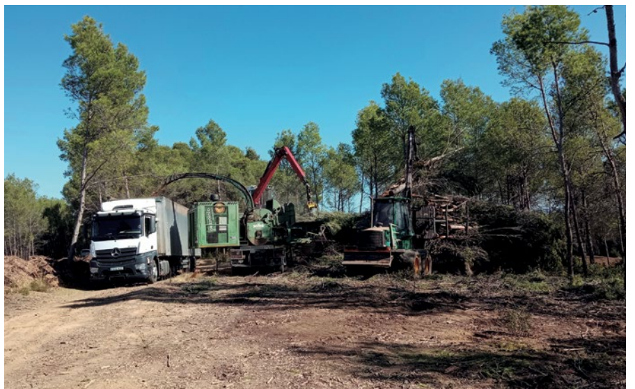
Màquines treballant en les feines de la zona dels Masos (tardor 2022).
