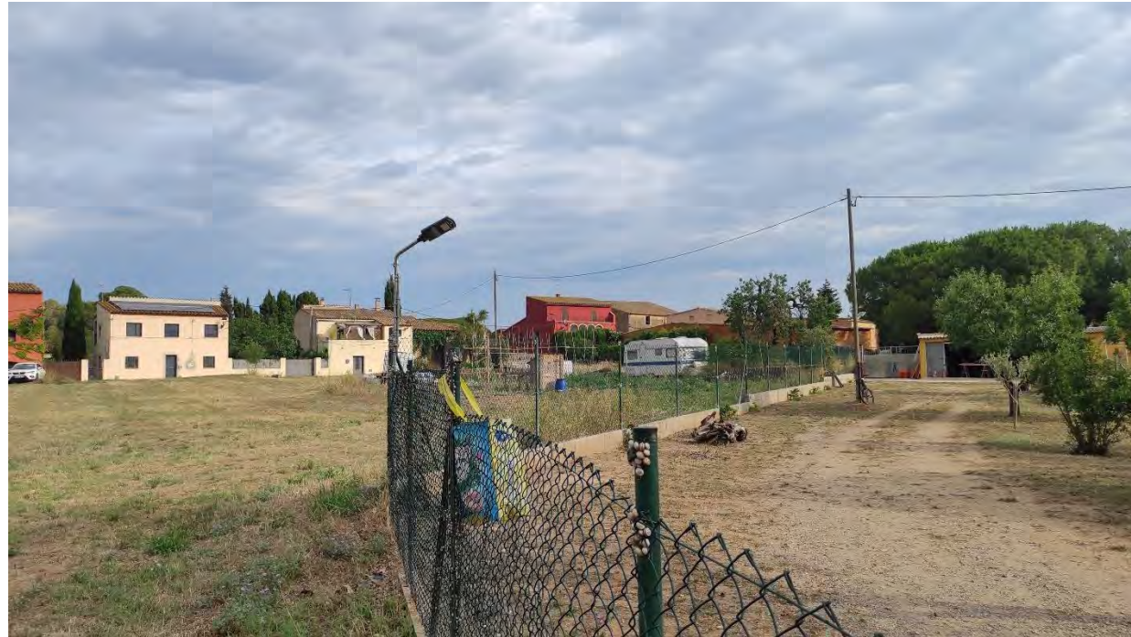
Foto4. Retirar línia aèria existent amb 2 suports de fusta
