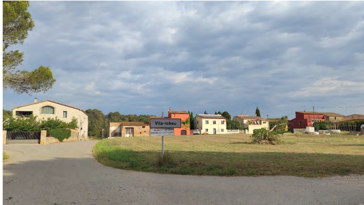
Foto1. Ubicació del nou suport de formigó HV-630-11m
