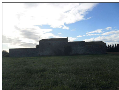
VISTA GENERAL NORD
