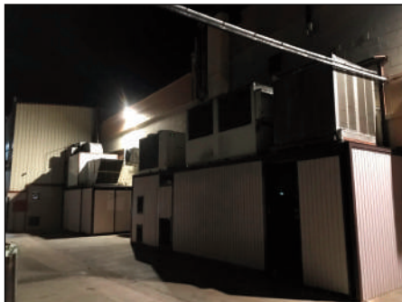
Foto 1. Cobert dels compressors i unitats exteriors de les refredadores sobre els coberts.
